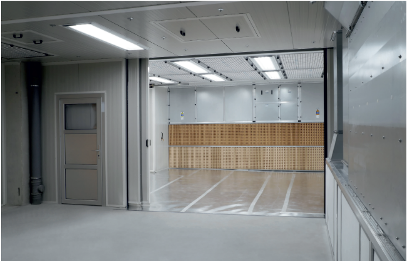
Lackierkabinen mit integrierter Zu- und Abluft, EX-Beleuchtung und Wärmerückgewinnung
